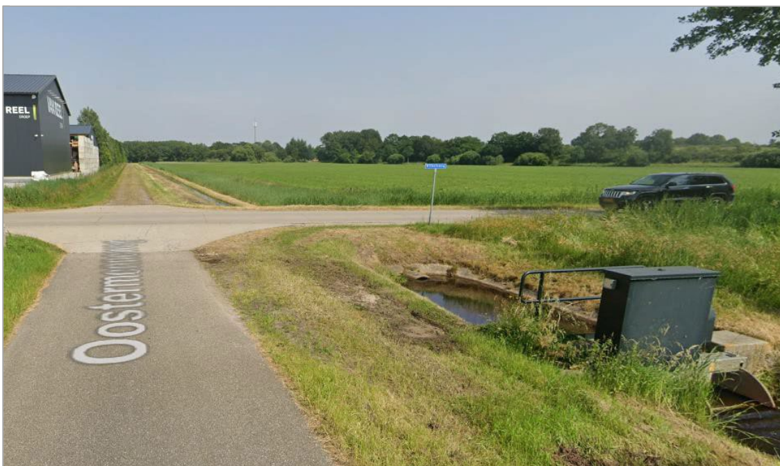
Afbeelding 11: Knijpconstructie nabij kruising Oostermenneweg/Uithofsweg
