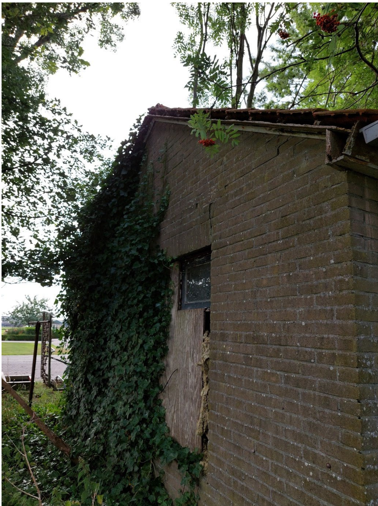
Afbeelding 5: Gebouw aan de Dekkersweg 8a. Situatie op 18 juli 2022.
