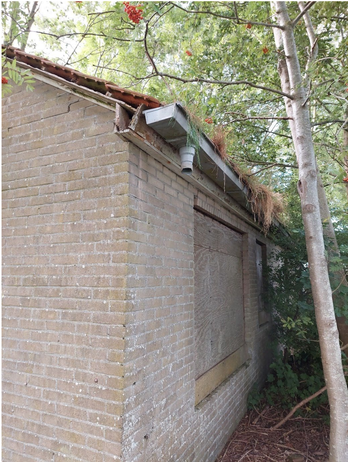
Afbeelding 4: Gebouw aan de Dekkersweg 8a. Situatie op 18 juli 2022.
