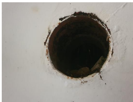
Diverse doorvoeren (metaal)
