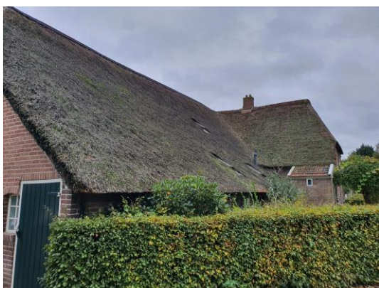
Schoorsteen en dak
