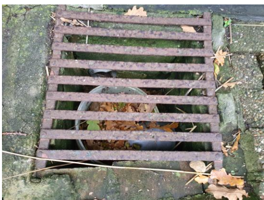
Putten en riolering (pvc)
