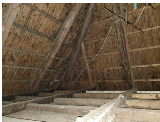
Dak en plafond
