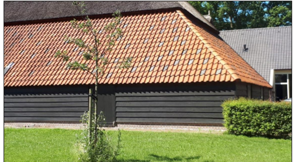
Figuur 9 Nieuwe gevelbekleding en dakbedekking dwarsschuur
