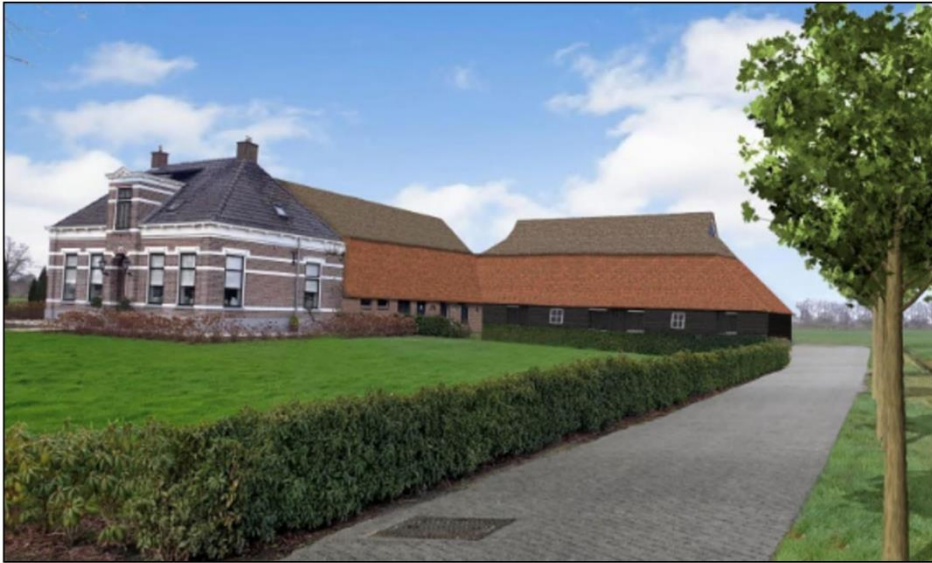
Figuur 8 Gerestaureerde karakteristieke boerderij met dwarsschuur
