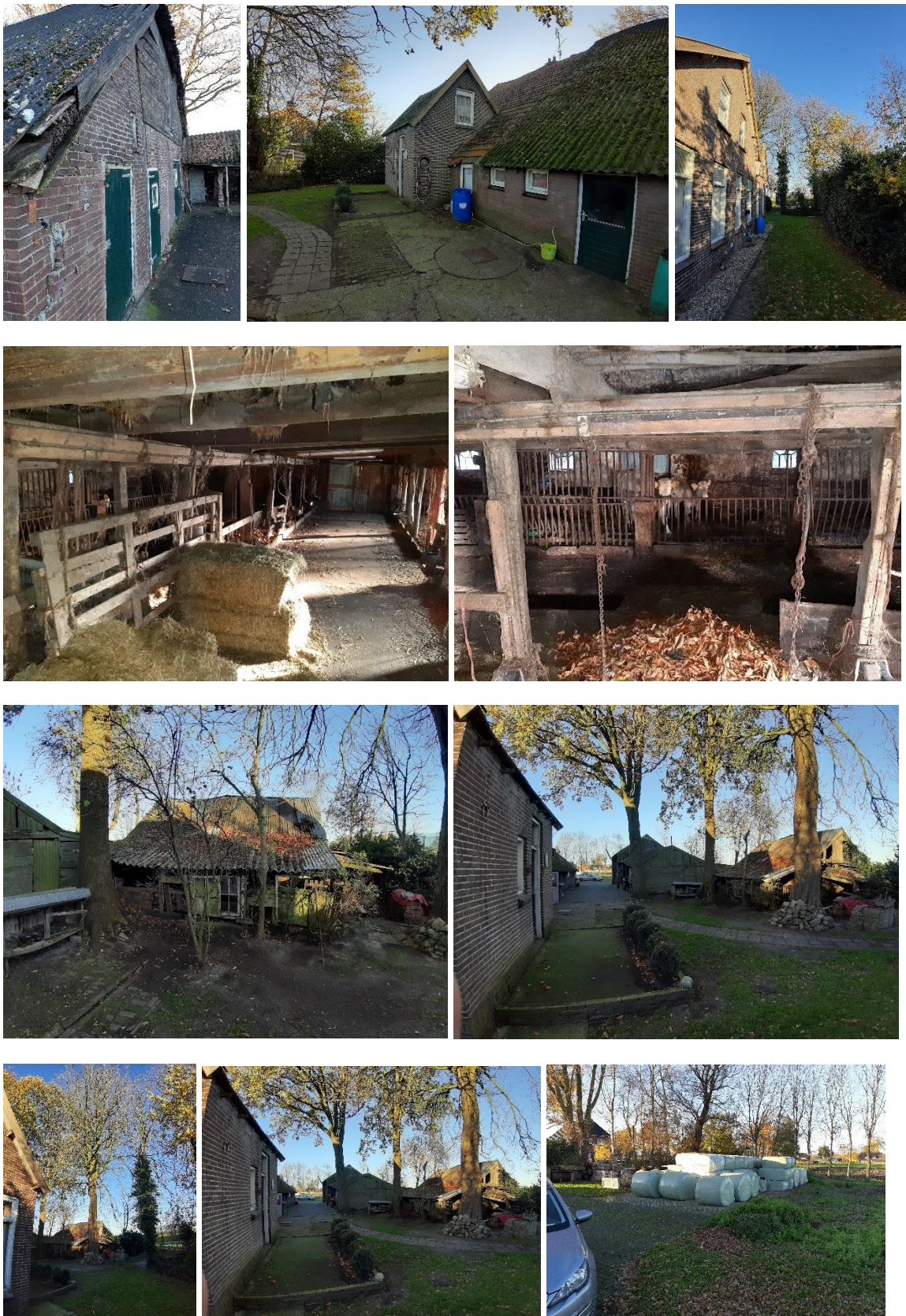
Figuur 2. Foto's bestaande situatie
