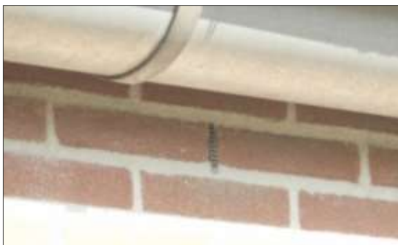
Roosters in de stootvoegen voorkomen dat vleermuizen de spouw kunnen betreden.
