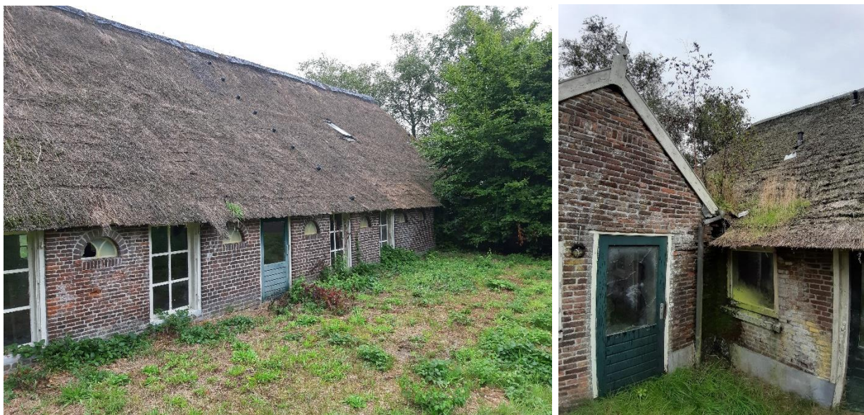
Figuur 2. Foto met de te slopen boerderij.
