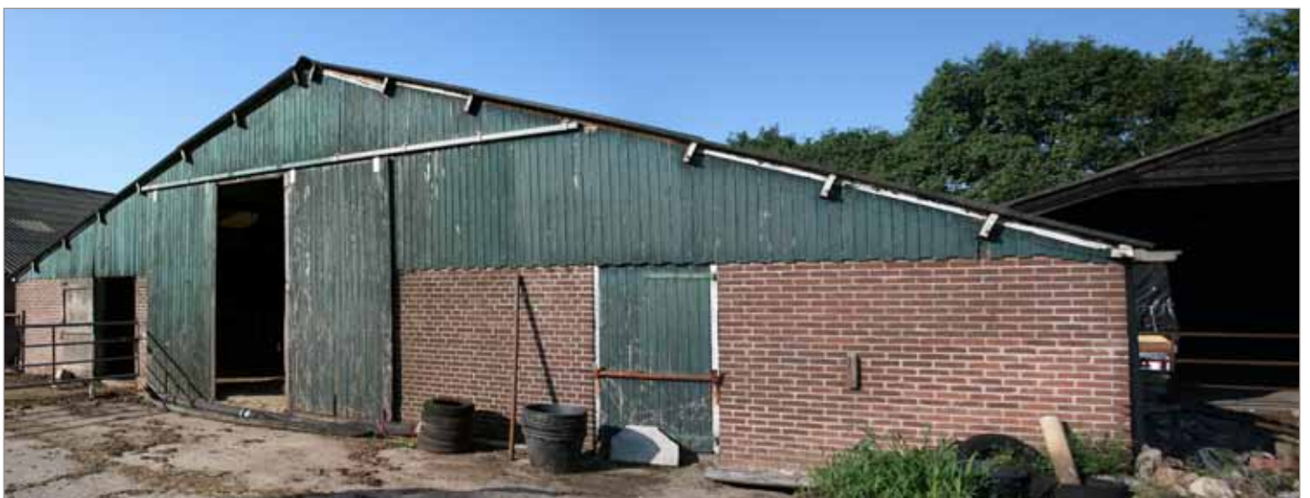
Afbeelding 26. Te slopen stal
