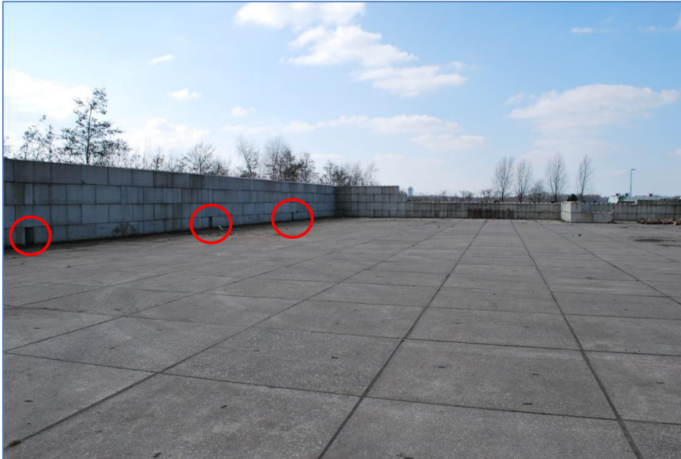
Figuur 2-f, foto keerwand zuidelijke inrichtingsgrens GRR met de kleine openingen (rood omcirkeld)
