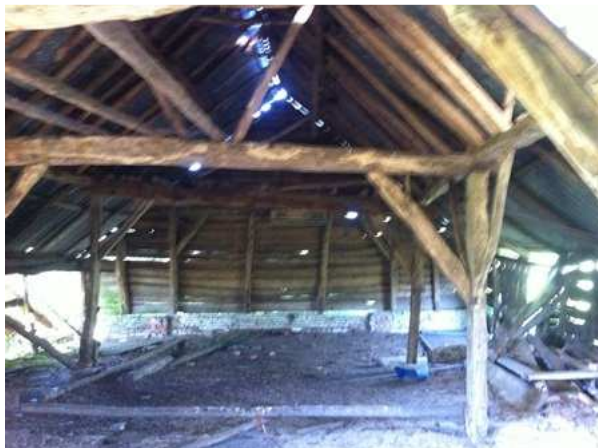
Aanblik op de wanden en dak van het gebouw. Ongeschikt als verblijfplaats voor vleermuizen.
