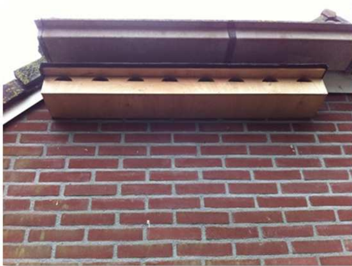
Één van de twee opgehangen 'huismussenflats' aan de achterzijde van de woning.
