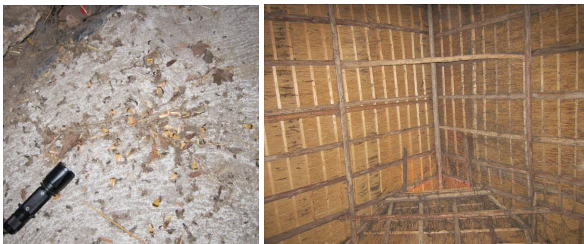
Figuur 4: Sporen van de Gewone grootoorvleermuis (links) en opendak constructie zolder (rechts).
