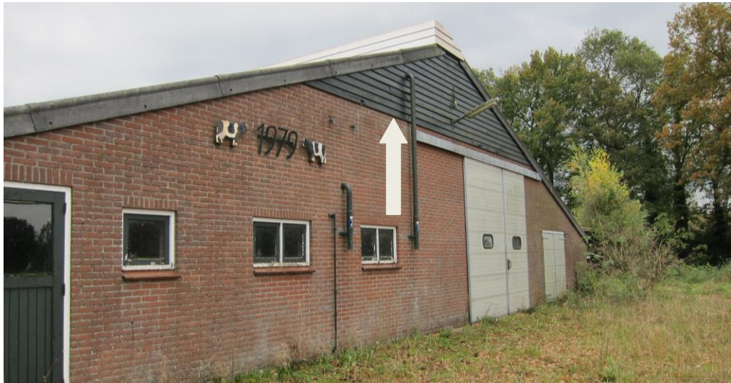
Figuur 5: Mogelijke verblijfplaatsen vleermuizen achter gevelbetimmering (foto's SAB, 2012)
