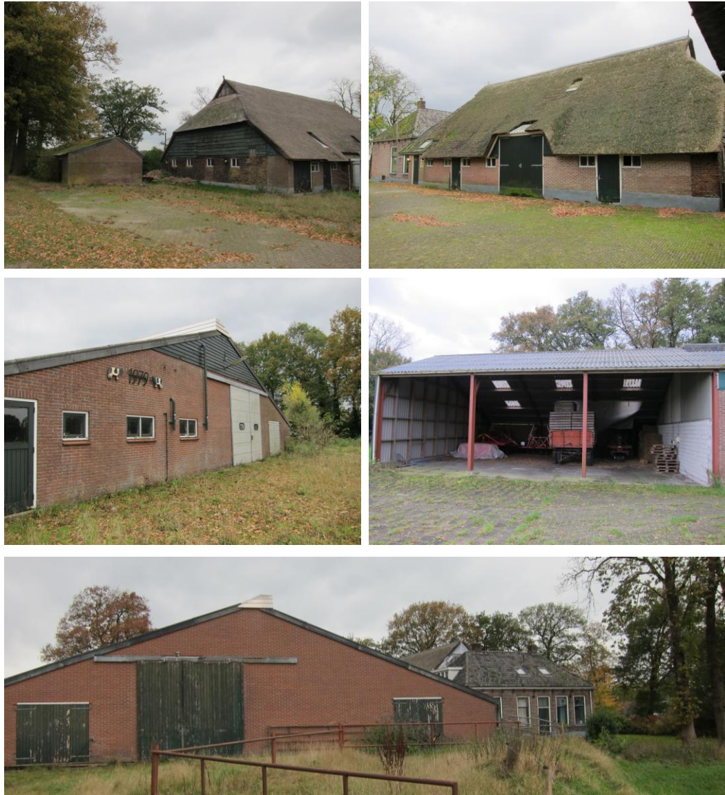
Figuur 2: Globale indruk plangebied; te behouden woonhuis met aangebouwde schuur (boven), te slopen koeienstal (linksmidden), te behouden kapschuur (rechtsmidden) en te slopen koeienstaal met het te behouden woonhuis (onder) (foto's SAB, 2012)
