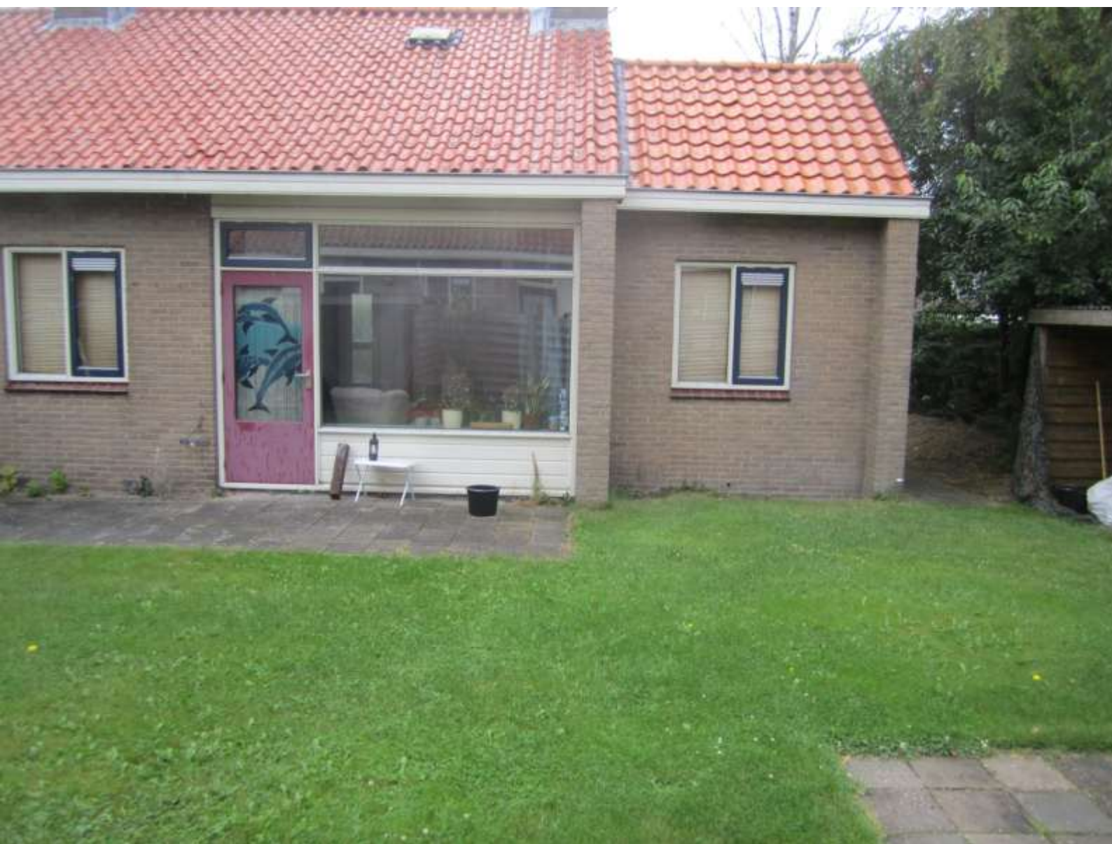
Foto 1. Zicht op een van de af te breken woningen.
