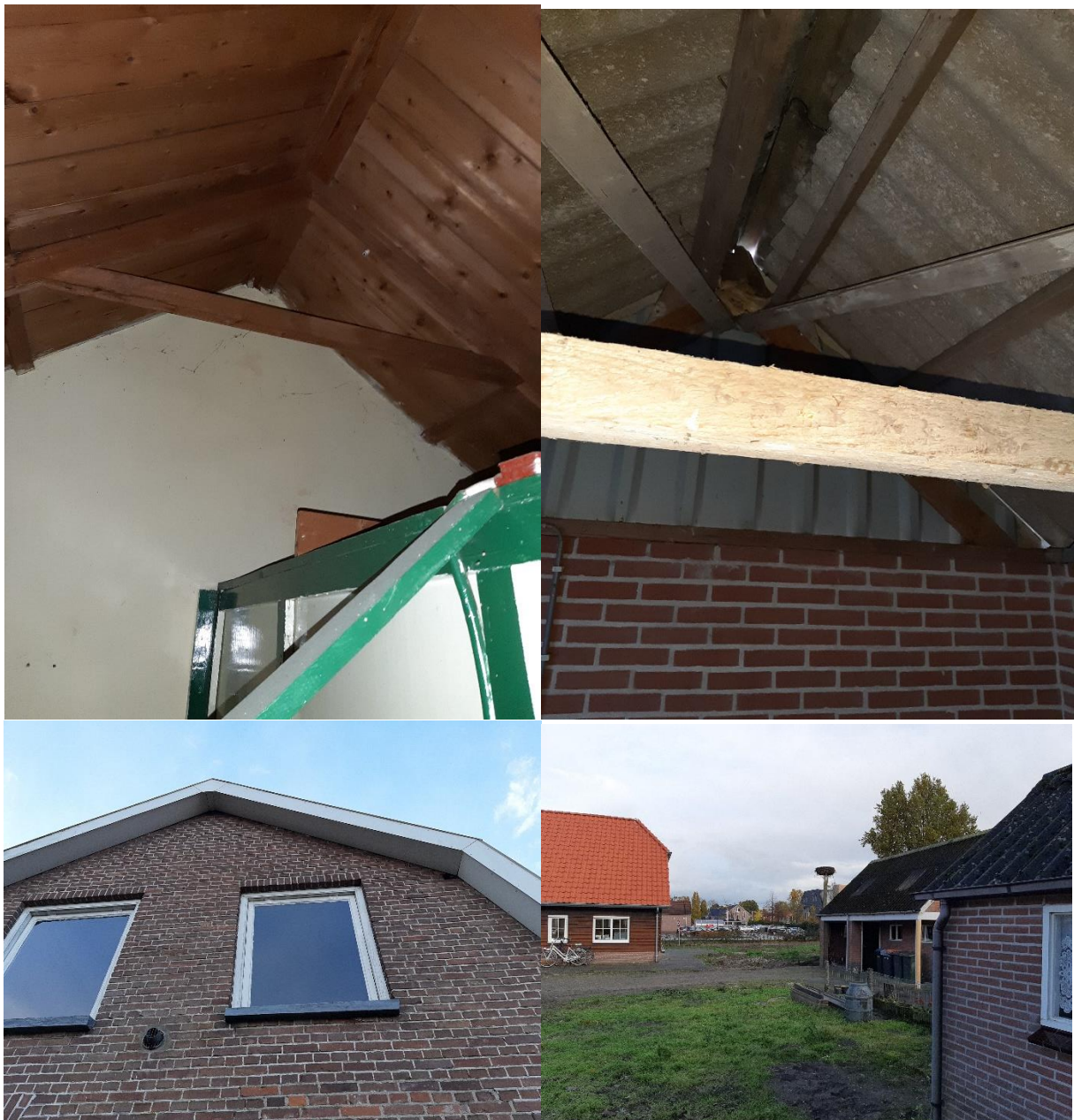
Figuur 3. Detailfoto's lb zolder huis, rb dak schuurtje, lo dakrand, ro vooraan schuurtje in de verte ooievaarspaal.
