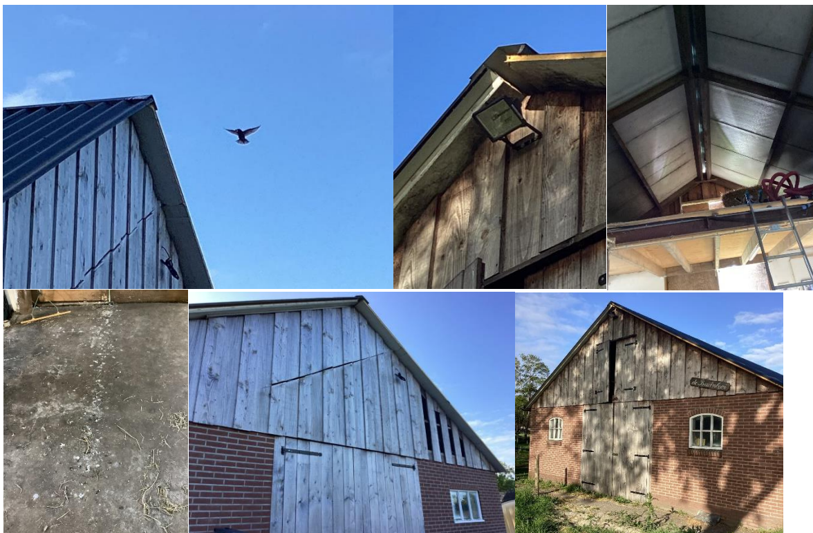
Figuur 5: A) Aankomende volwassen zwaluw. B) Nok waar de gierzwaluwen binnen kunnen komen. C) Nok met verschillende (oude) nesten. D) Rand met uitwerpselen onder de nesten. E) Gleuven in achterwand waar gierzwaluwen door naar binnen kunnen. F) Openstaand hooiluik in de voorgevel waar gierzwaluwen door naar binnen kunnen.
