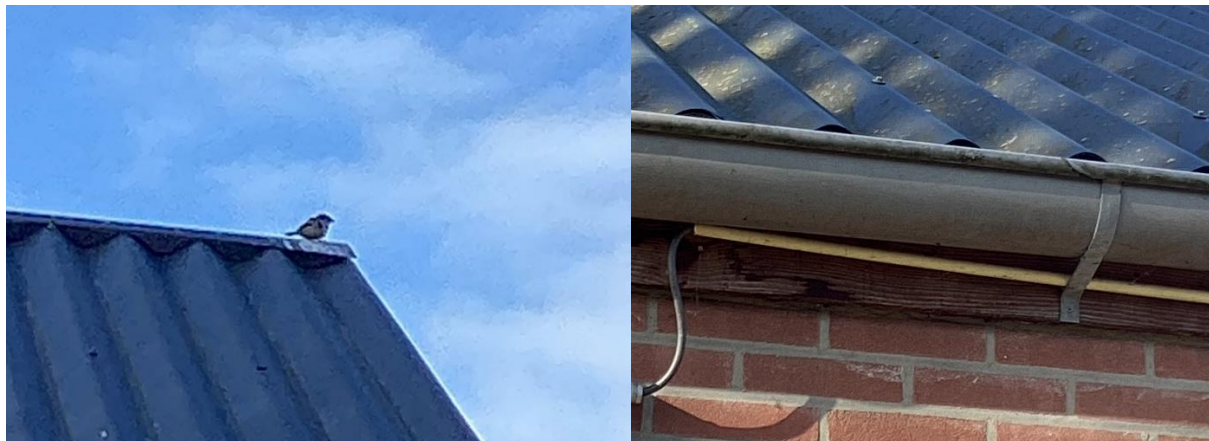
Figuur 6: A) huismus op dak van te slopen schuur. B) Het golfplaten dak wat geen nestgelegenheid voor huismussen biedt.
