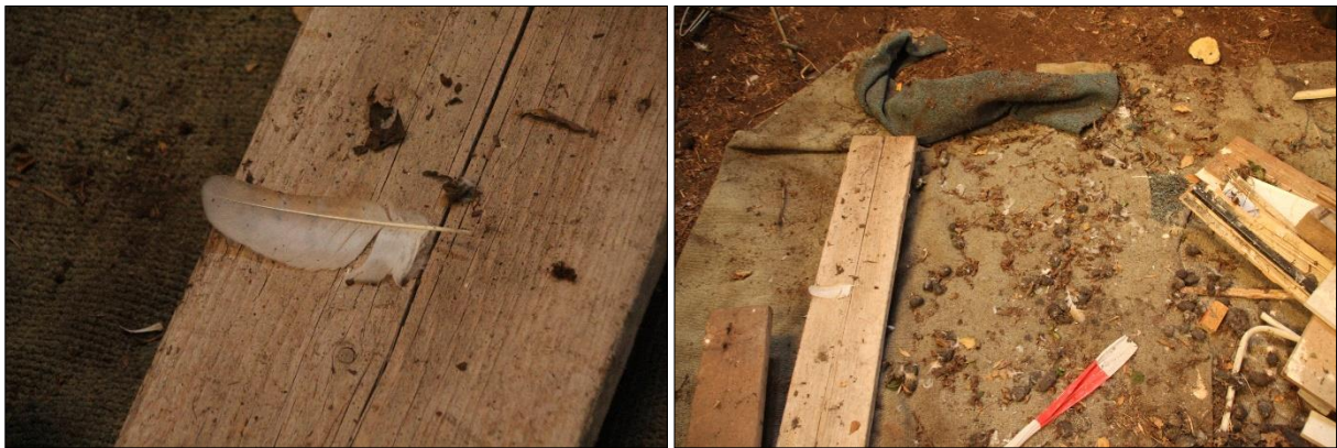
Ruiveren en braakballen van kerkuilen aangetroffen in de te behouden karakteristieke schuur.
