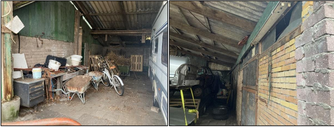
Figuur 2.5 (links): De westzijde van de kapschuur, hier vindt opslag plaats van materialen; Figuur 2.6 (rechts): De achterzijde van de kapschuur. Hier bevinden zich oude stallen waar paarden in hebben gestaan.
