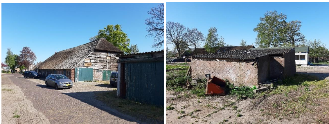
Figuur 2. Foto's bestaande situatie
