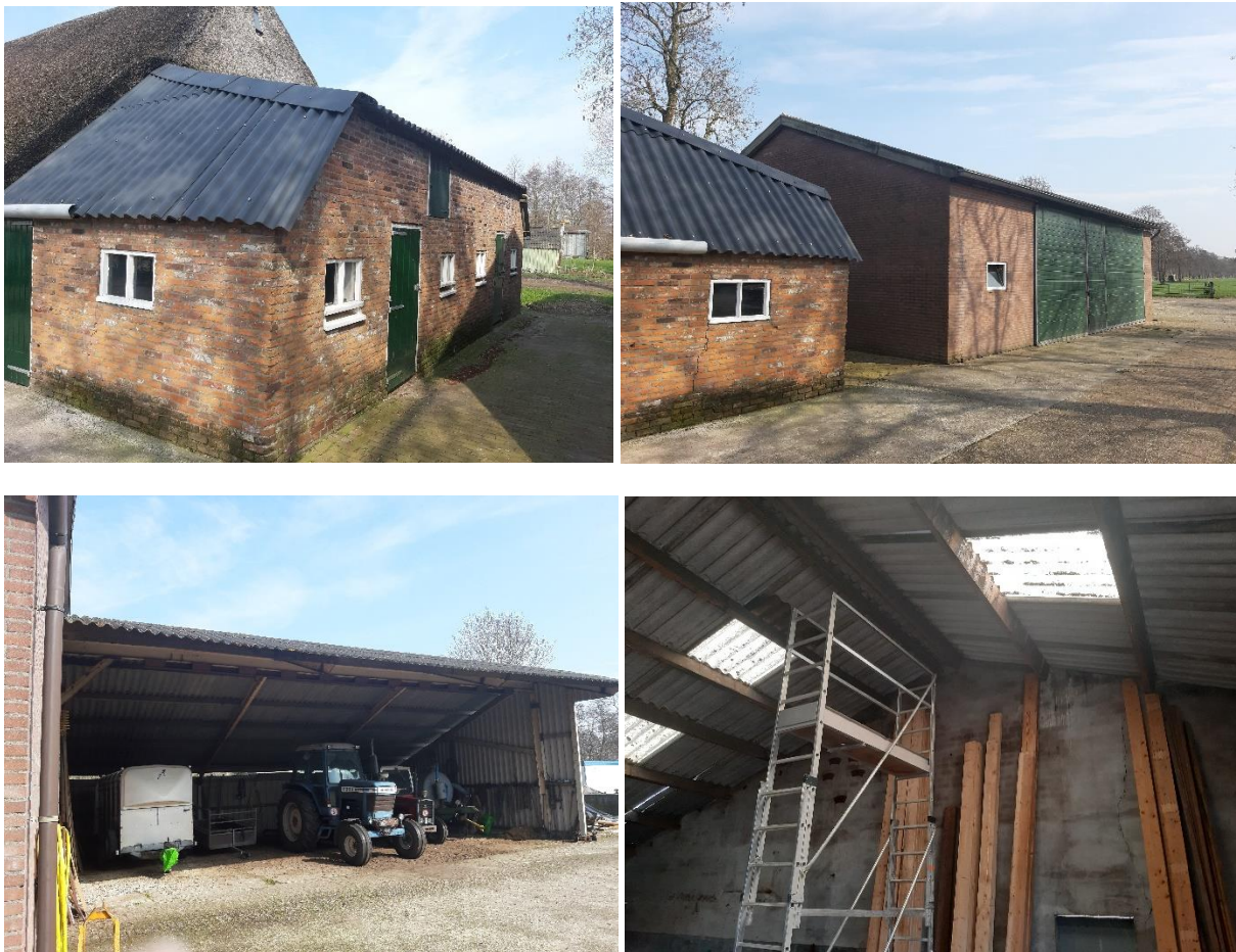
Figuur 2. Foto's bestaande situatie (van lb naar ro: aanbouw, loods, kapschuur, binnenkant loods)
