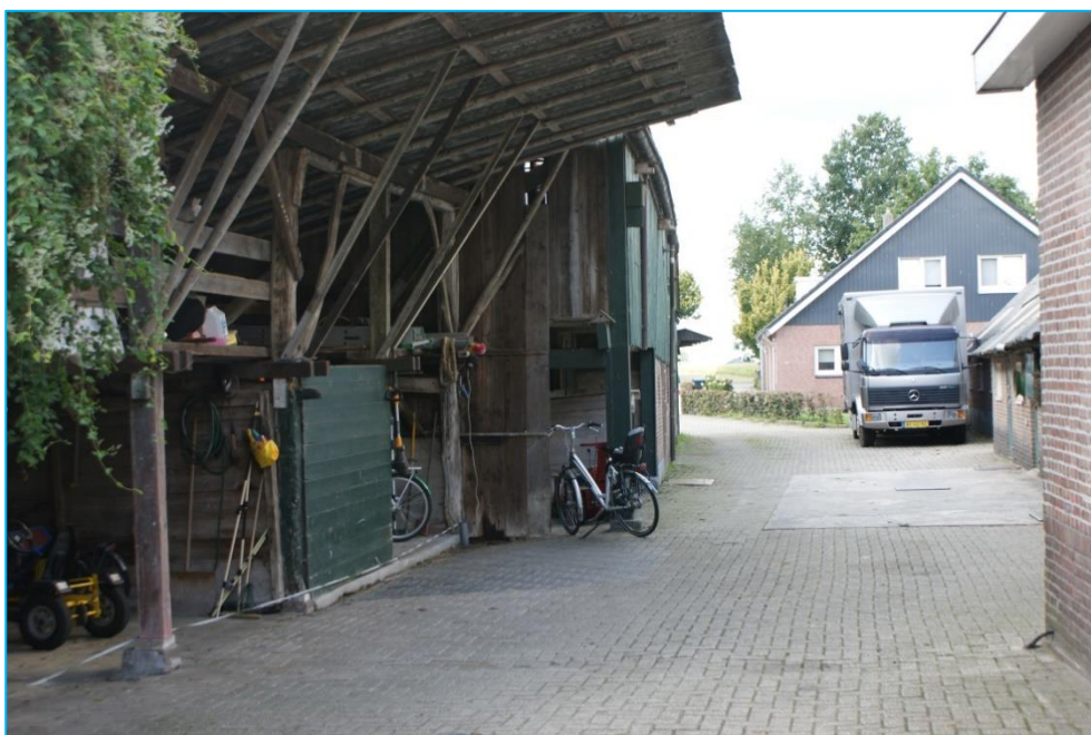
Fig. 4.2 Weergave van de kapschuur gezien vanaf de boerderij Oude Rijksweg 617, met zicht op de woning Oude Rijksweg 615.
