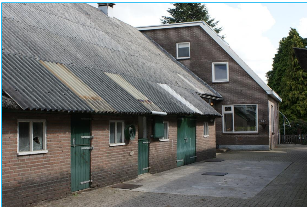
Fig. 4.1 Het bestaande schuurgedeelte voor de kop van de boerderij (gezien vanaf de steeg t.h.v. Oude Rijksweg 615)
