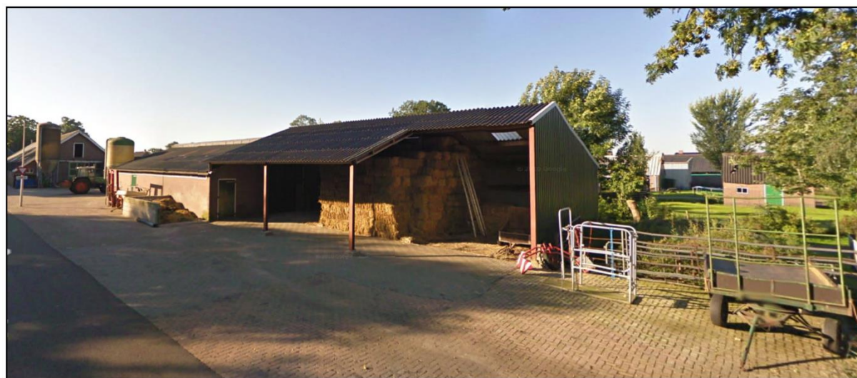
Afbeelding 2.3 Zicht vanaf het de Reggersweg op de bedrijfsbebouwing (Bron: Google Streetview)
