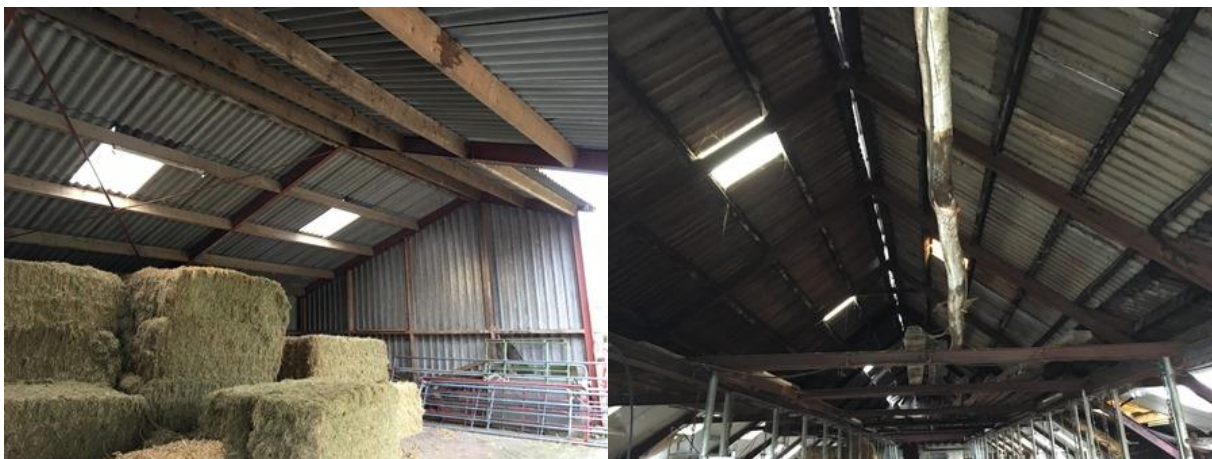
Potentiële nestplaats voor vogels. Soorten als merel, houtduif en holenduif kunnen nestelen op de balken van de gording of van de zijgevels.
