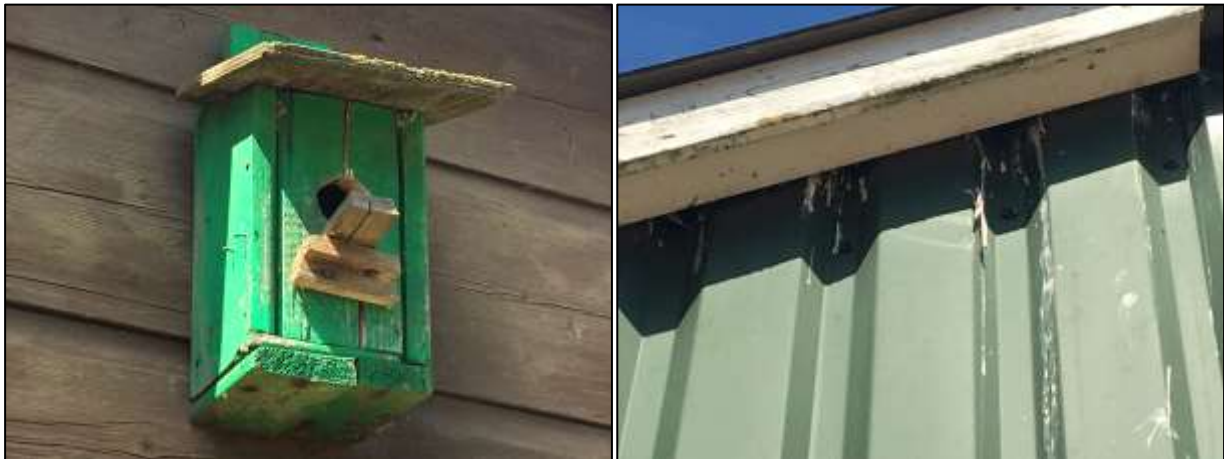
Foto links: een van de aanwezige vogelhuisjes in het plangebied. Foto rechts: sporen van bezette spreeuwnesten in de te slopen berging.
