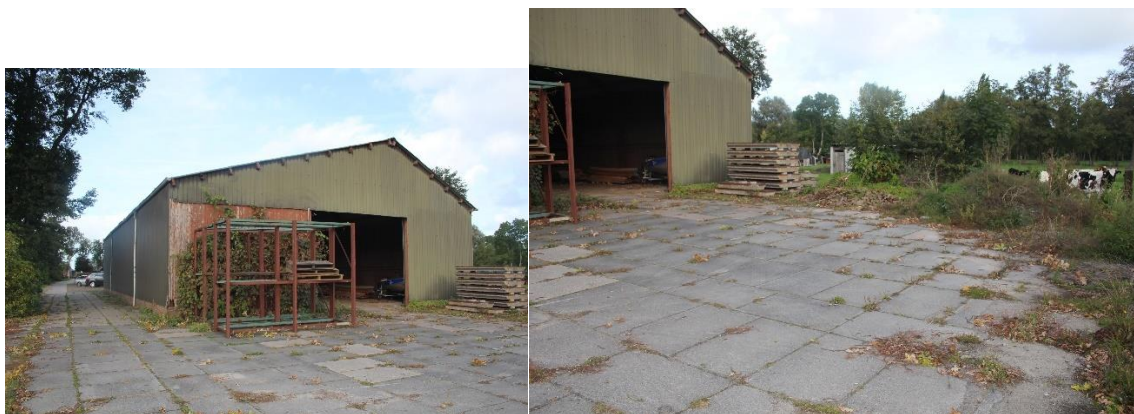
Figuur 3. Foto met de te slopen berging en de toekomstige bouwlocatie.
