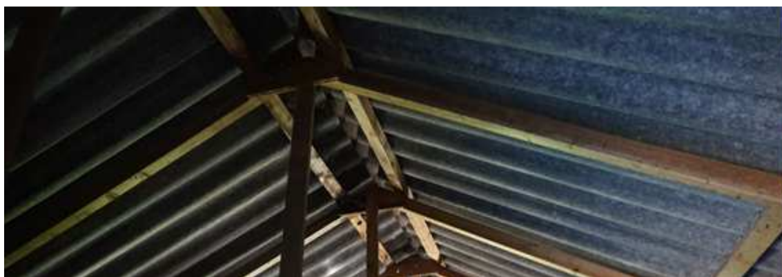
Figuur 5.1 Dakbedekking zonder dakbeschot in schuur.
