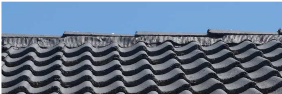
Figuur 5.2 Afwerking nok woning met ondervorsten.
