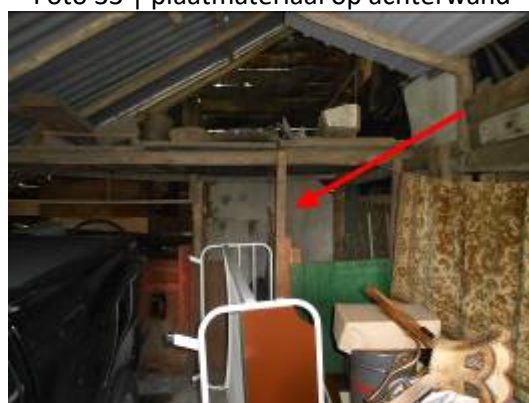
Foto 35 | plaatmateriaal op achterwand
