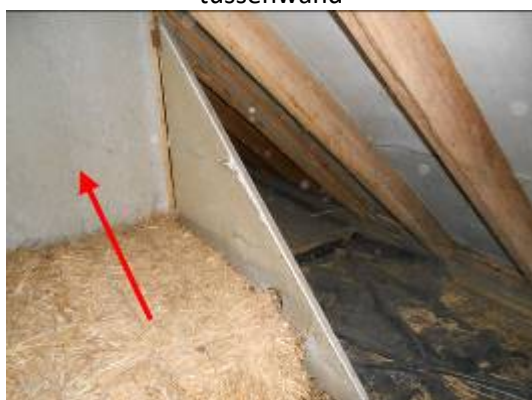
Foto 13 | brandwerende beplating op tussenwand
