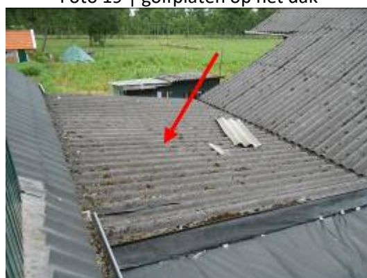
Foto 21 | golfplaten op het dak
