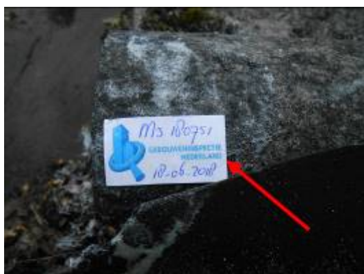
Foto 18 | golfplaten op het dak
