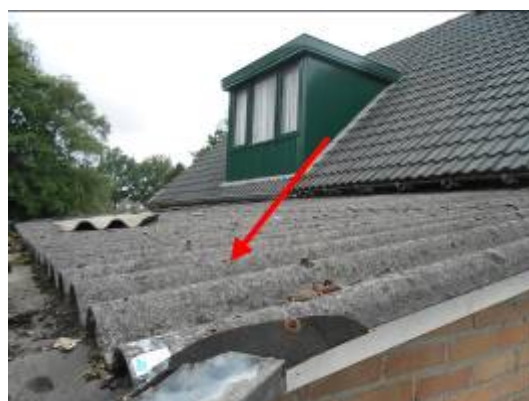
Foto 19 | golfplaten op het dak
