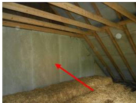
Foto 12 | brandwerende beplating op tussenwand
