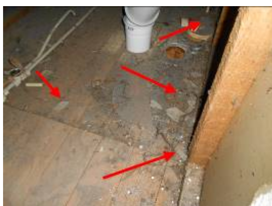
Foto 7 | restanten dakbeschot achter knieschot
