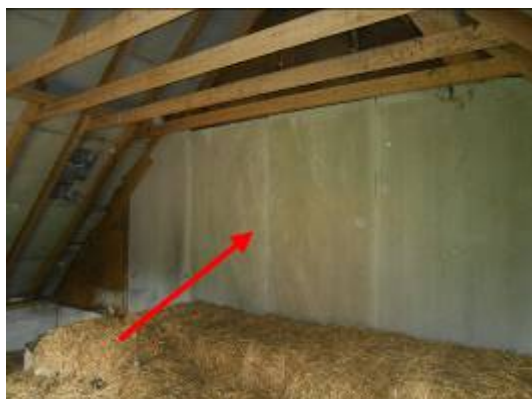
Foto 11 | brandwerende beplating op tussenwand
