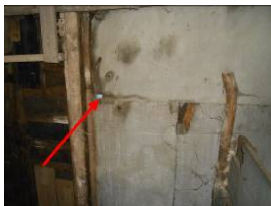
Foto 33 | plaatmateriaal op achterwand
