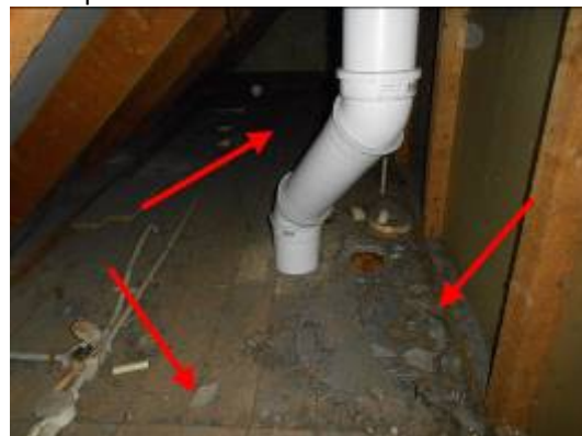
Foto 10 | restanten dakbeschot achter knieschot
