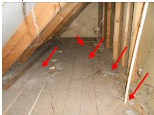
Foto 9 | restanten dakbeschot achter knieschot
