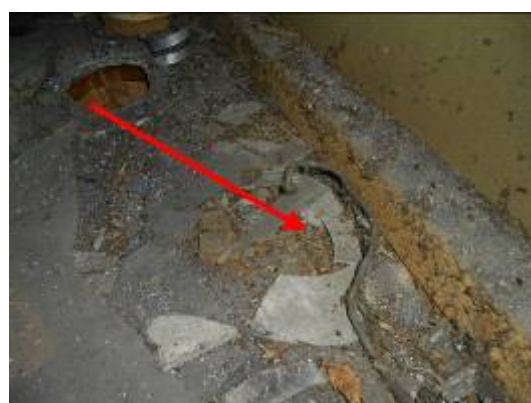
Foto 8 | restanten dakbeschot achter knieschot
