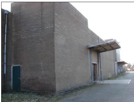
Zuivelfabriek richting de Gemeenteweg
