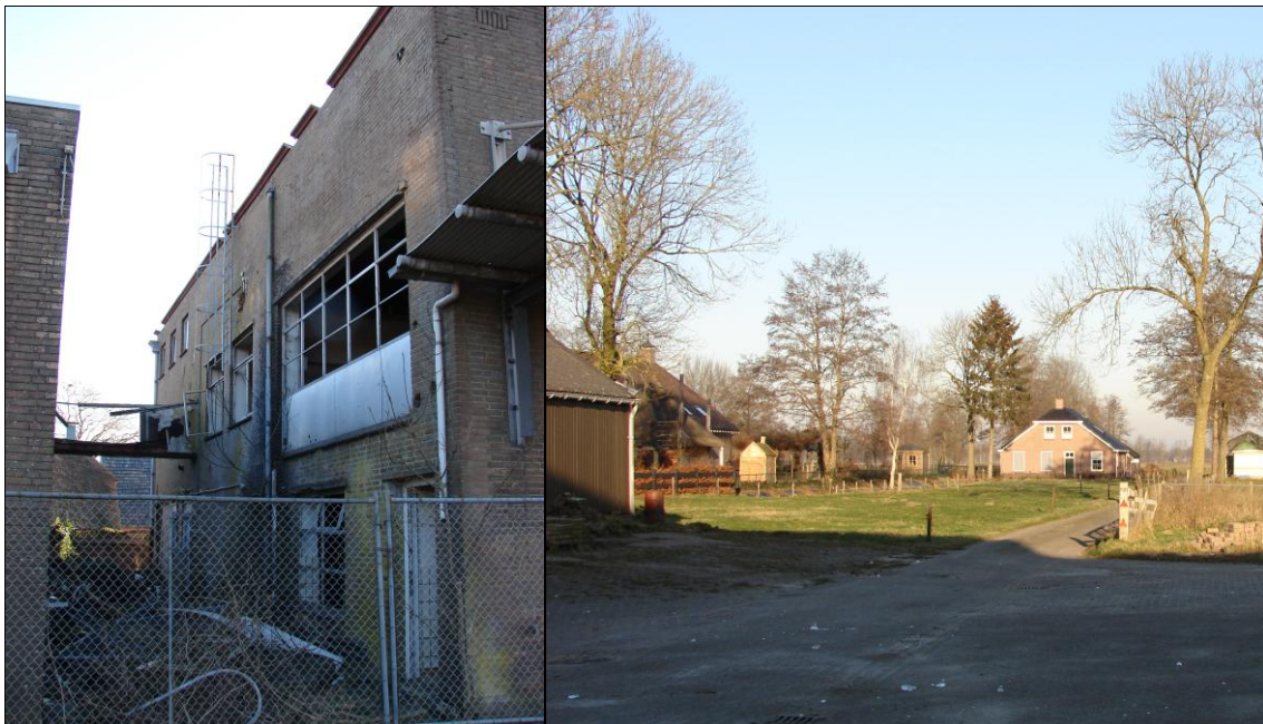
Deel van het fabrieksgebouw
