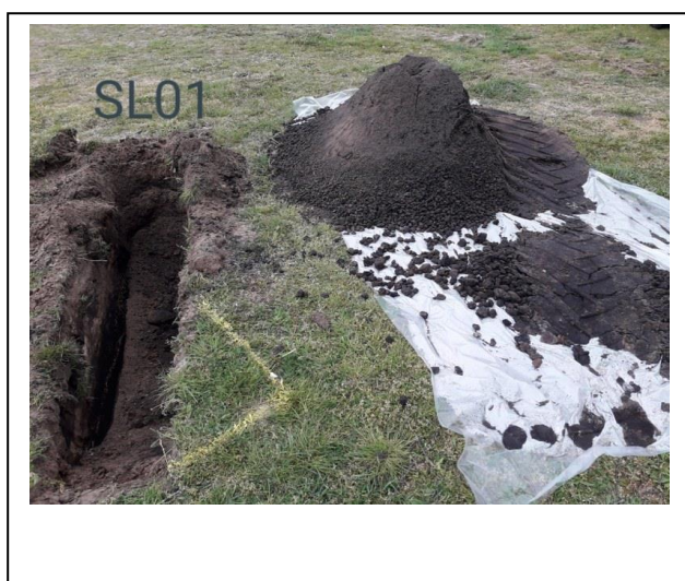
Foto: Inspectiesleuf SL01
