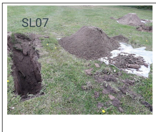
Foto: Inspectiesleuf SL07
