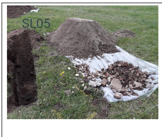
Foto: Inspectiesleuf SL05
