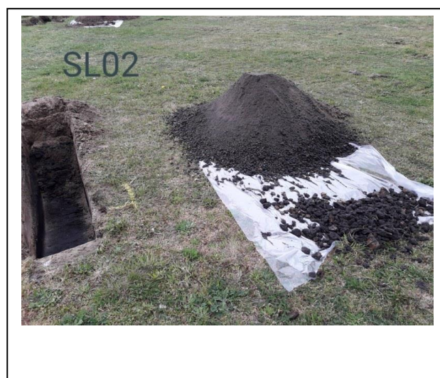
Foto: Inspectiesleuf SL02
