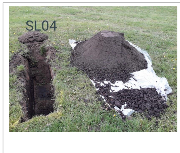
Foto: Inspectiesleuf SL04
