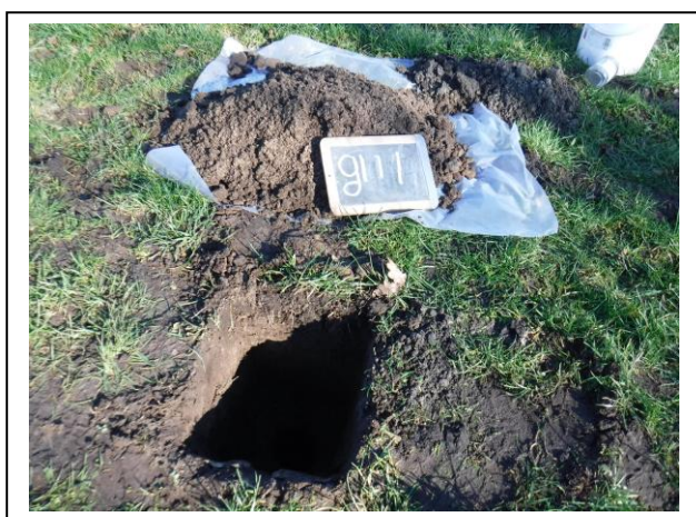
Foto: Inspectiegat G111
