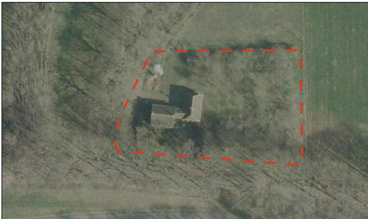
Figuur 2.1 Luchtfoto invulling plangebied (Bron: Provincie Overijssel)
