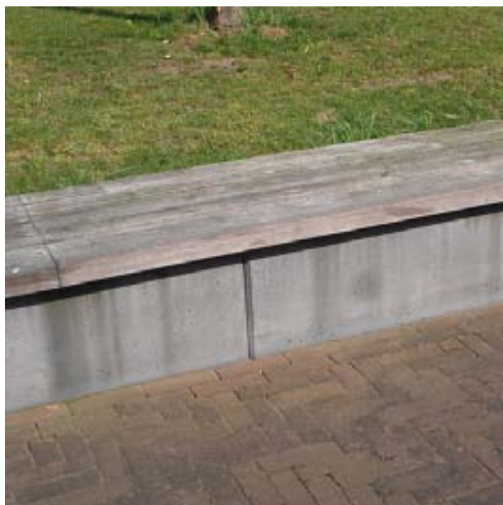
de keerwand van het verlaagde plein dient tevens als zitrand, 45 cm hoogteverschil
