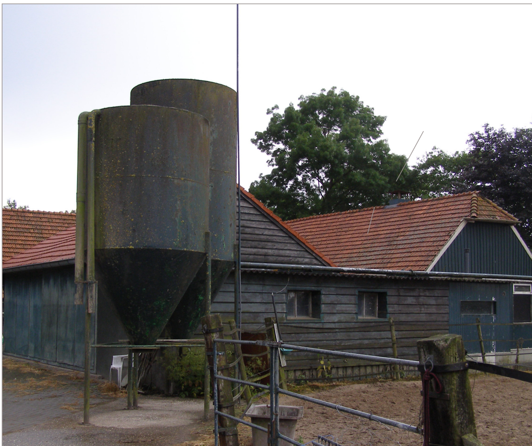
Afbeelding 4. Te slopen bebouwing
