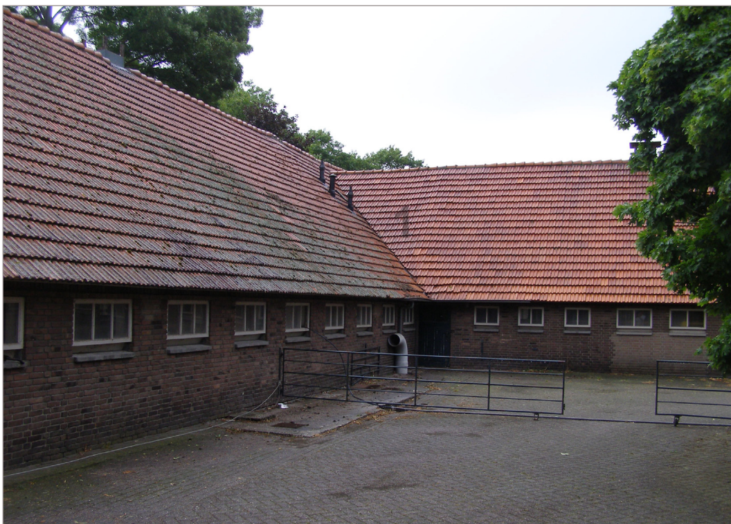
Afbeelding 5. Te slopen bebouwing
