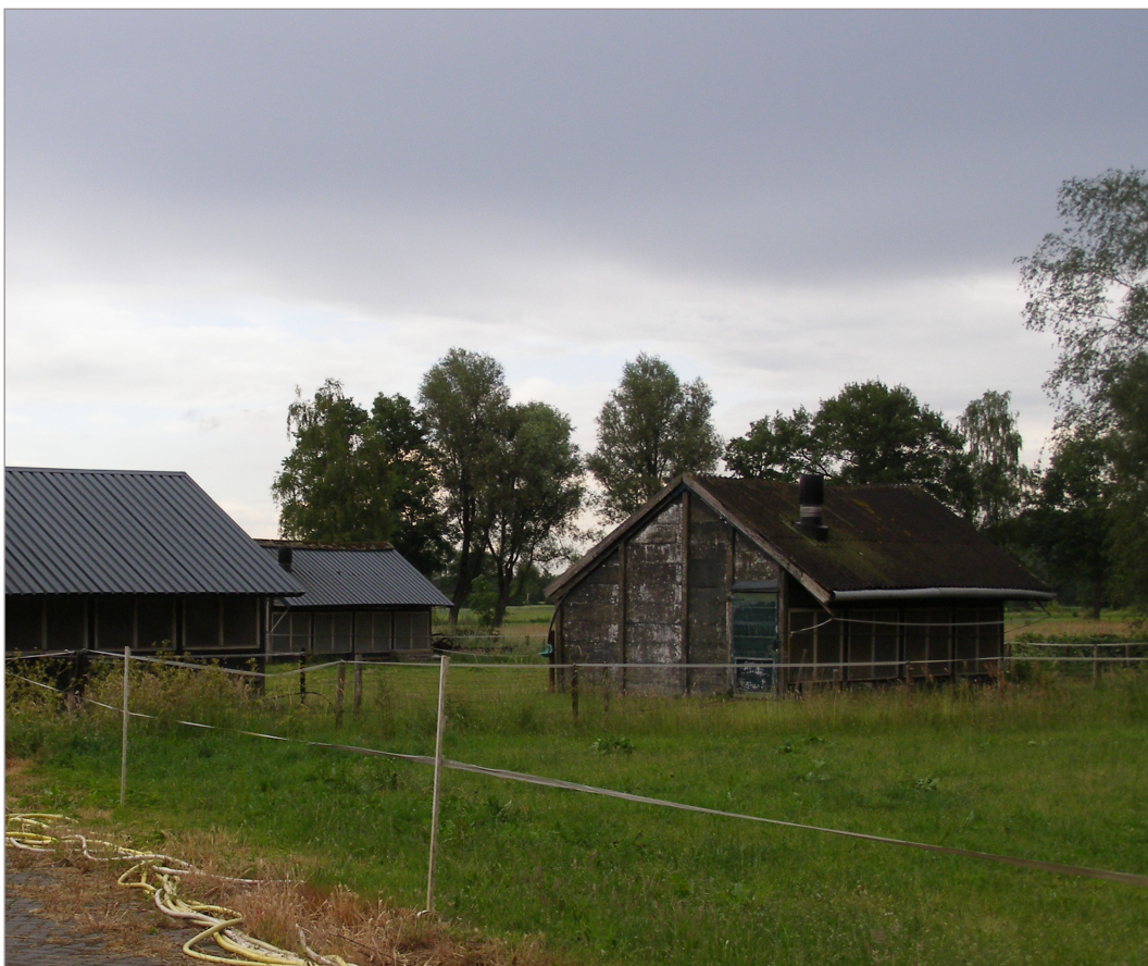
Afbeelding 6. Te slopen bebouwing
