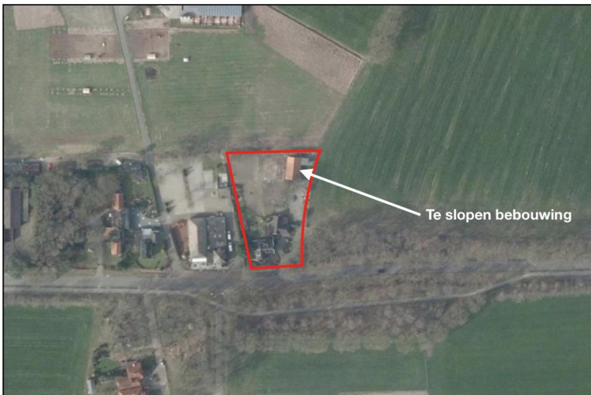
Afbeelding 3.1 Te slopen bebouwing op het perceel Lemelerveldseweg 39a (bron: PDOK)
