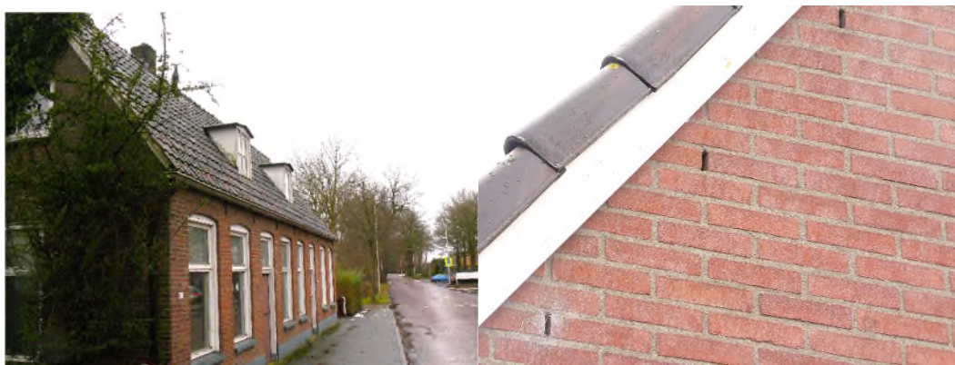
Afbeelding 5.2 a) Impressie van de bebouwing in het plangebied, b) open stootvoegen in de bebouwing.
