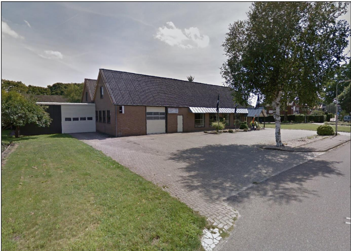
Afbeelding 2.3 Straatbeeld vanaf de Haven Oost (Bron: Google Streetview, 2017)
