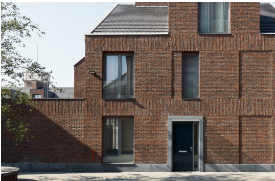
Verbijzondering in metselwerk
