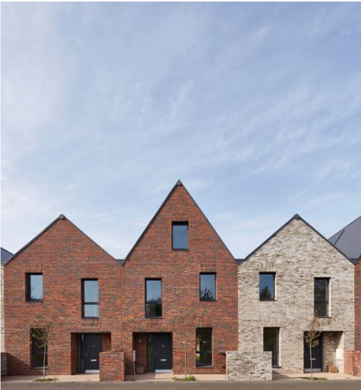
Speelse gevel, verschil in materiaalgebruik
