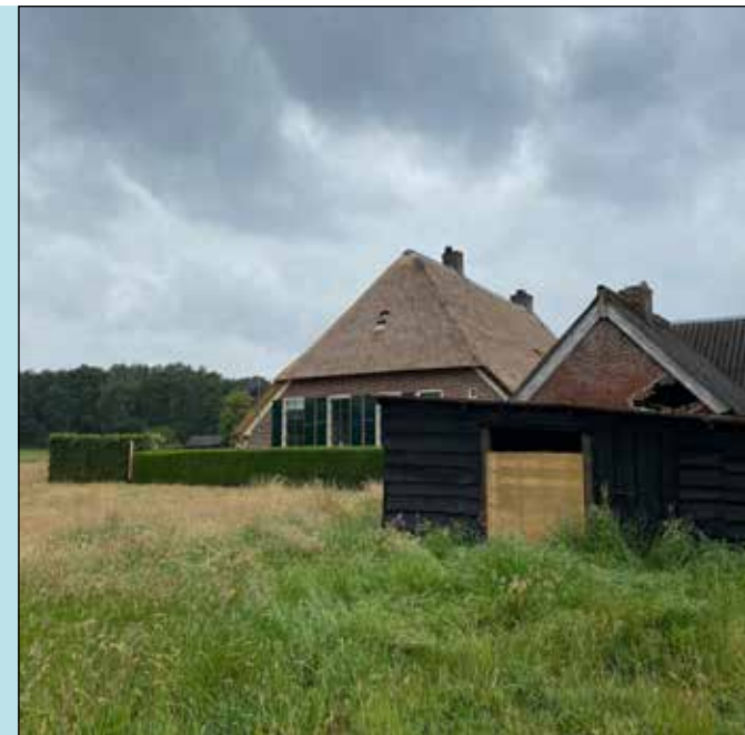
de te slopen houtstek aan karakteristiek bakhuis
