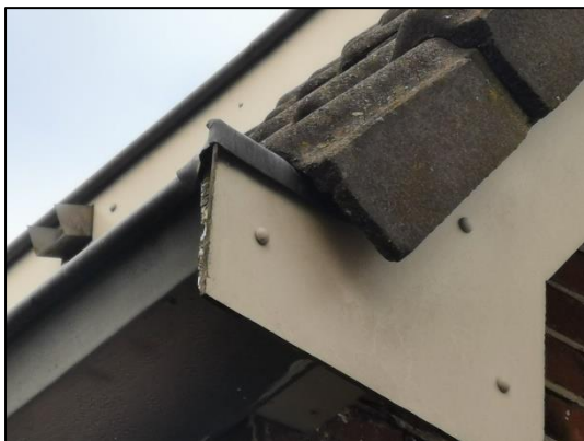
Figuur 6.1: De dakpannen van de bedrijfsbebouwing.
