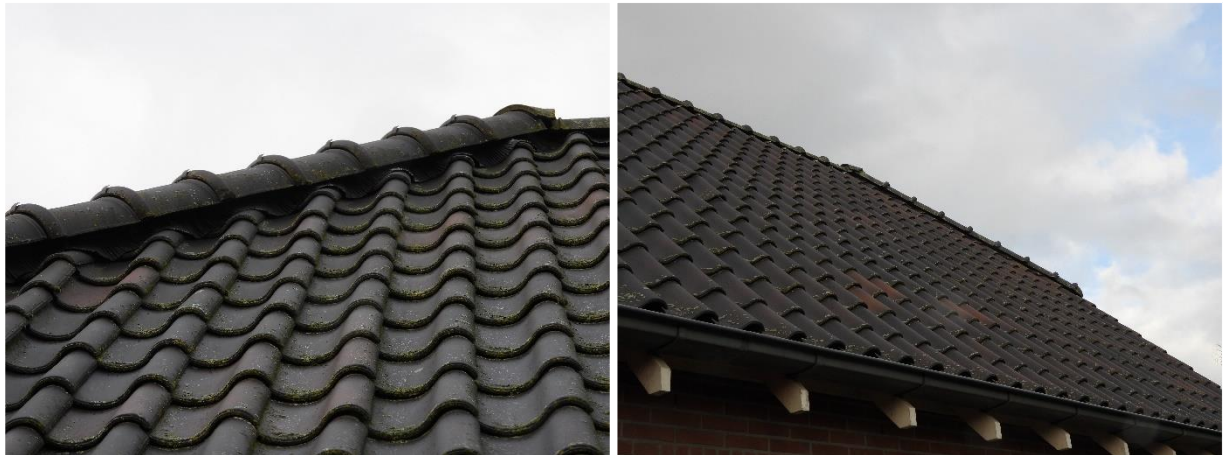
De dakpannen op het gebouw sluiten nauw aan en vormen geen nestplaats voor gierzwaluwen.
