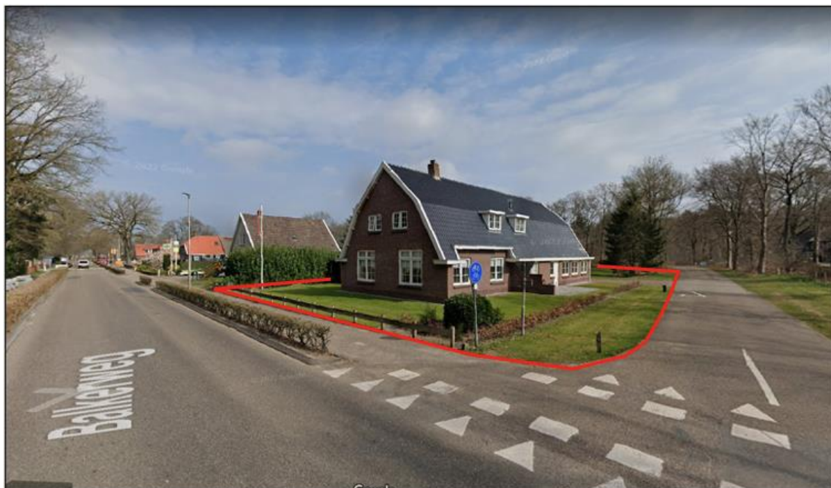
Afbeelding 2.3 Aanzicht voorgevel huidige situatie vanaf de kruising (Bron: google maps, Streetview, maart 2022)
