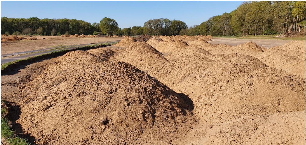
Figuur 3. Referentie beeld van zanddepots voor aanleg rivierduinen. Deze worden later door kraan in golvend reliëf gebracht.
