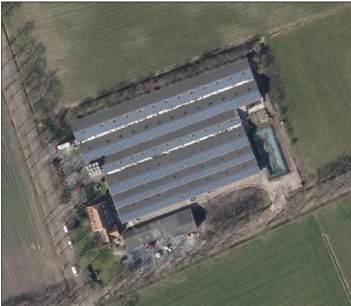
Afbeelding: Luchtfoto projectlocatie
