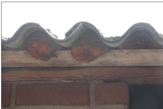
Gaten onder de golfplaten zijn afgedicht met hardschuim.
