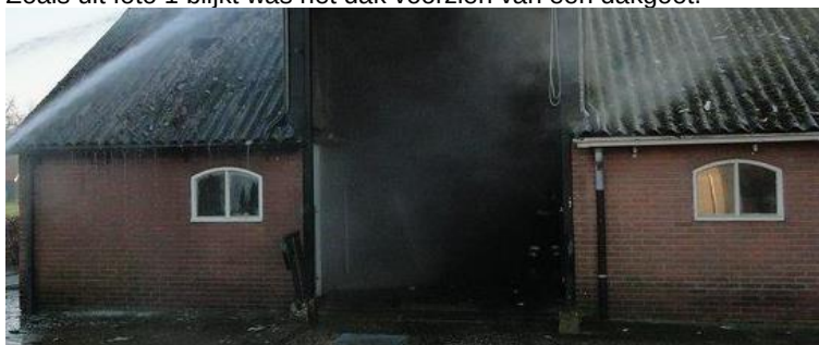
foto 1: asbestdak van de schuur met dakgoot
