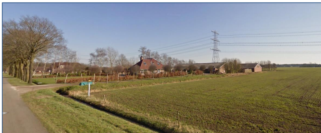
Fig. 2.4: Het plangebied gezien vanaf de Woestenweg, met zicht op de bedrijfswoning en de 2 te slopen schuren achter op het perceel
