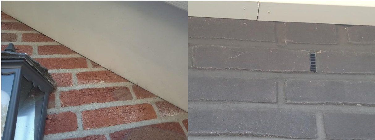
Foto links; de betimmering van het dak overstek sluit naadloos aan op de buitengevels. Foto rechts; de open stootvoegen zijn afgesloten met bijenbekjes.
