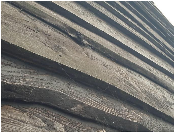
De planken sluiten strak op elkaar aan.
