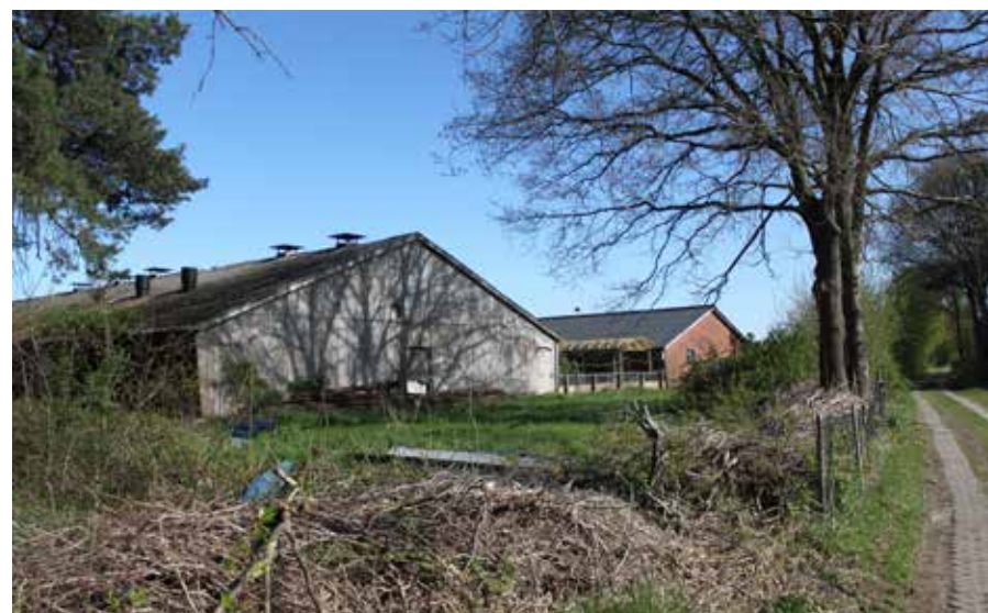
Afbeelding 7. Aan de westkant van het erf is een zandweg aanwezig. De rechter schuur is de locatie van de toekomstige nieuwe woning, de linker schuur wordt gesloopt.
